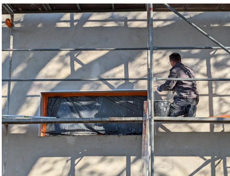
Fot. 1. Nakładanie tynku piaskowo-wapiennego na siatce z włókna szklanego
