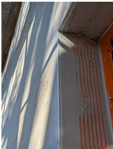
Fot. 2. Obróbka narożników okiennych w systemie VestaEco WALL
