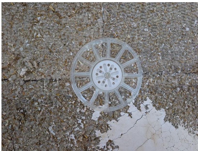
Fot. 3. Montaż łączników mechanicznych z systemowymi talerzami dociskowymi
