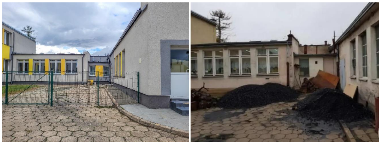
Zdj. 1 Po lewej stronie obiekt po modernizacji, wyposażony w pompę ciepła jako źródło ciepła. Po prawej stronie obiekt przed modernizacją, z instalacją opartą na węglu kamiennym.
