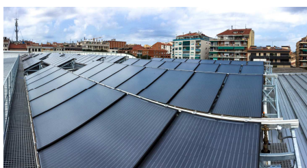
Rysunek 4: Kolektory PVT na dachu. Źródło: Abora Solar
