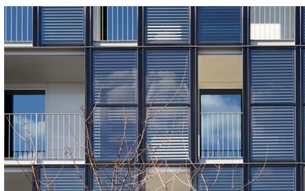
Rysunek 2: Połączenie aktywnych i pasywnych rozwiązań solarnych, z kolektorami słonecznymi stosowanymi jako urządzenia zacięniujące w elewacji. Źródło: Philippon-Kalt Architects
