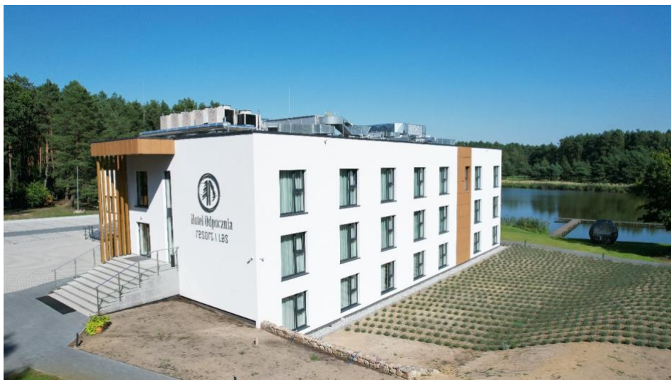
Rysunek 2. Urządzenia absorpcyjne zainstalowano na dachu hotelu.
