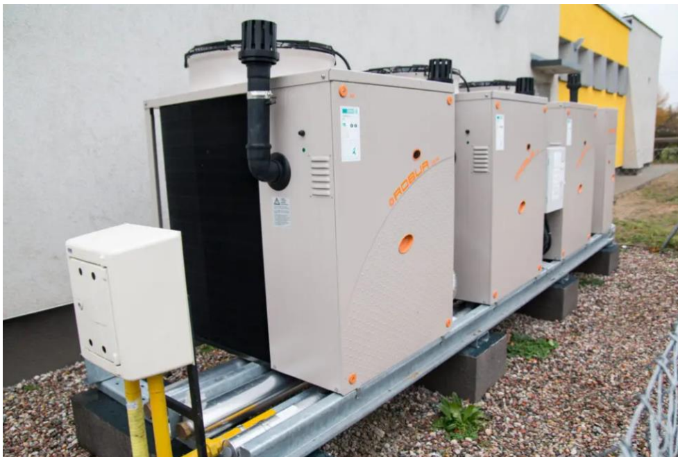
Rysunek 1. Przykład termomodernizacji z wykorzystaniem urządzeń absorpcyjnych - Szkoła Podstawowa w Jegłowniku.
