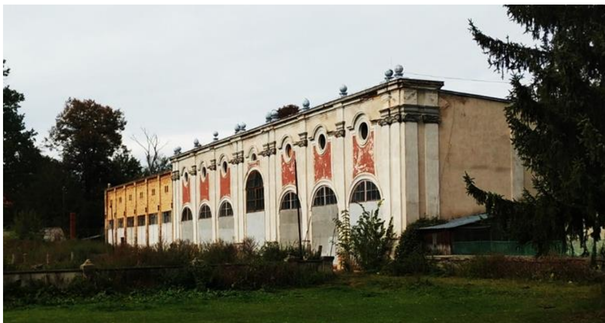
Rysunek 1 Budynek zabytkowej sali gimnastycznej.
