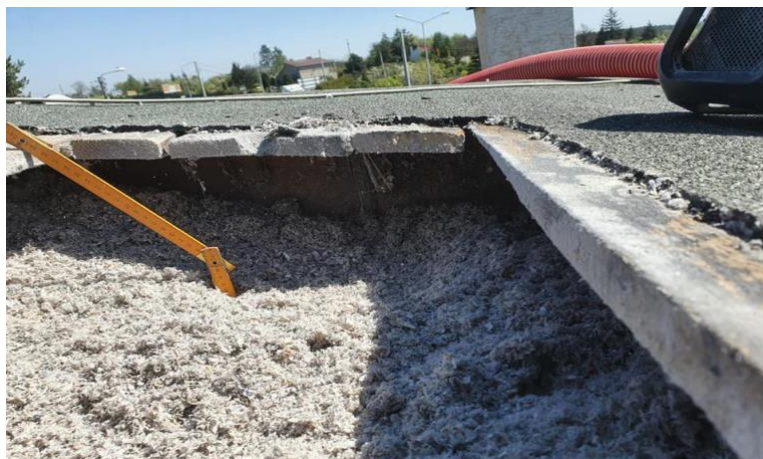
Ilustracja 1. Wełna celulozowa Isocell for you na stropodachu: grubość wbudowania.
