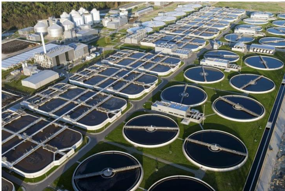
Zdjęcie 1. Oczyszczalnia ścieków 2
