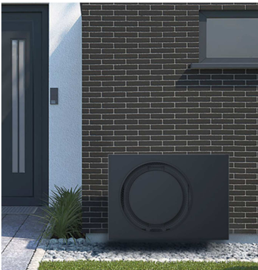
Rys. 8: Ukryta jednostka zewnętrzna skutecznie redukuje poziom hałasu
