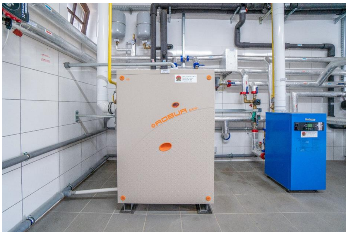
Zdj. 2 Źródło ciepła gruntowa absorpcyjna pomp ciepła GAHP-GS HT
