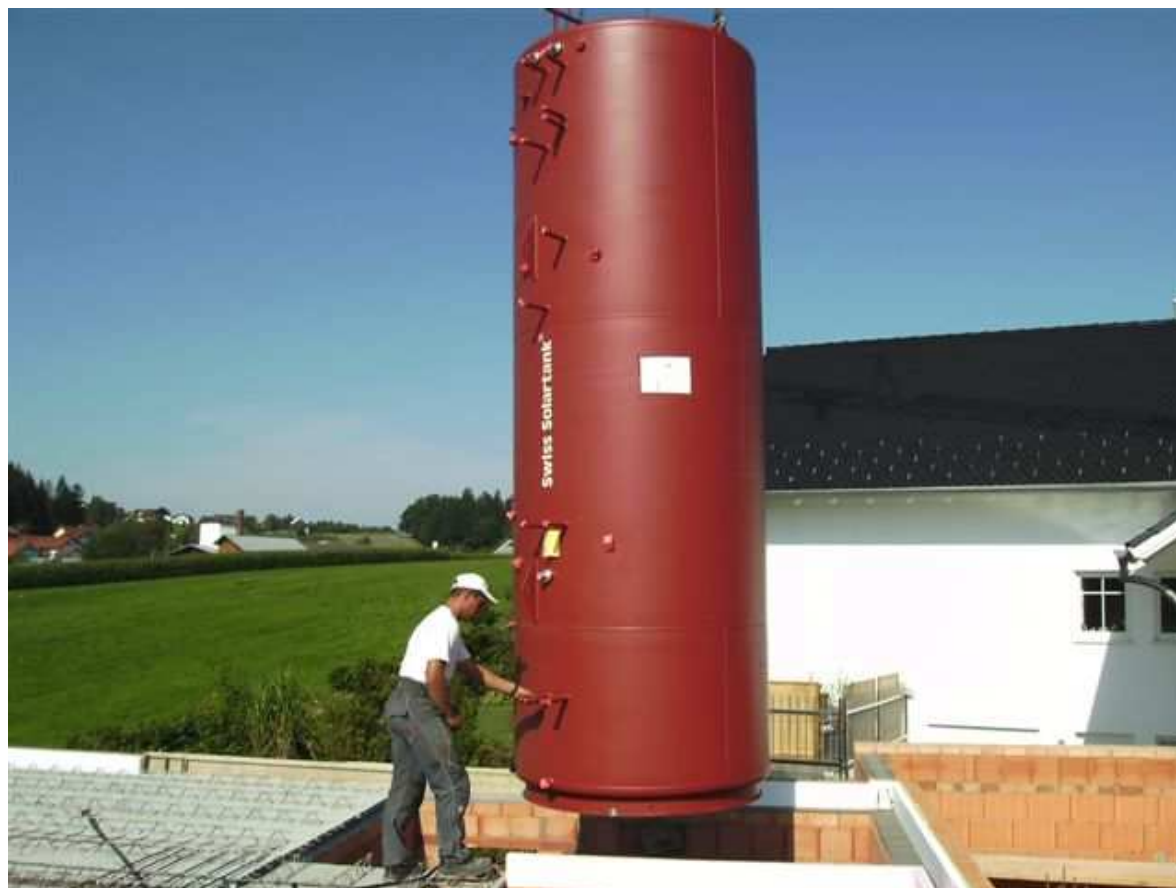
Rys. Warstwowy magazyn ciepła ( Źródło: Swiss Solartank)
