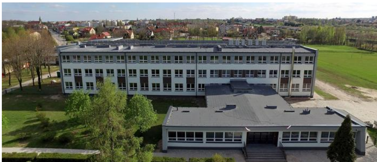
Fot. 1. Zespół Szkół Ponadpodstawowych nr 1 w Końskich po głębokiej termomodernizacji. Na dachu widoczne powietrzne pompy ciepła, centrala wentylacyjna oraz konstrukcja wsporcza paneli fotowoltaicznych. Fot. ZSP nr 1 w Końskich
