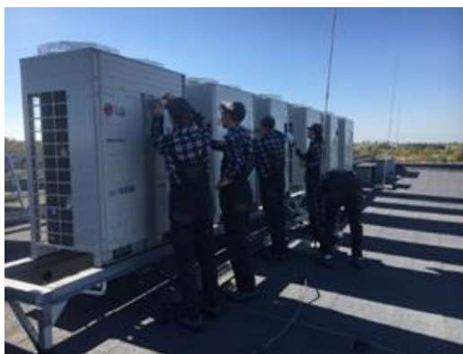
Fot. 2. Przyszli technicy elektrycy oraz technicy urządzeń i systemów energetyki odnawialnej podczas serwisu powietrznych pomp ciepła na dachu – dodatkowa korzyść z instalacji nowego systemu HVAC Fot. ZSP nr 1 w Końskich
