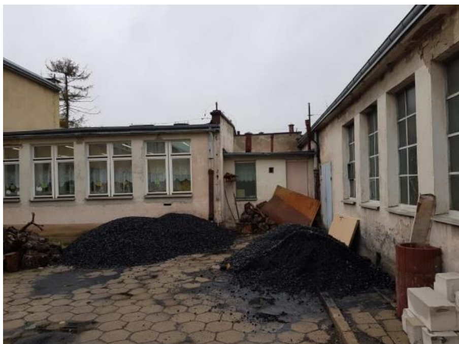
Zdj. Miejsce składowania opału przed termomodernizacją
