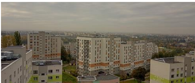
Fot. Klasyczne osiedle z wielkiej płyty w Sosnowcu – po głębokiej termomodernizacji. Na dachach widoczne elementy instalacji wentylacyjnej Fot. Frapol
