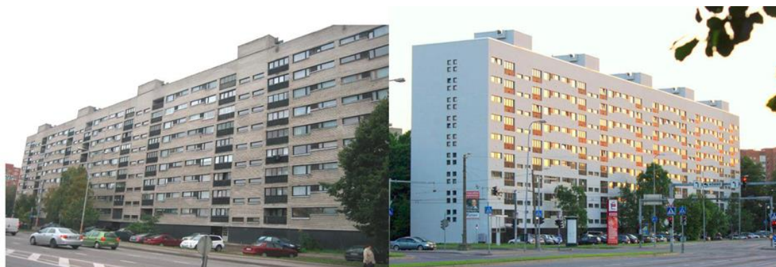
Fot. Liczący 162 mieszkania budynek w Tallinie, wyremontowany 2013 r. w pierwszym okresie dotacji (35% - najwyższy poziom dofinansowania). Pozostałe środki na remont uzyskano z kredytu. Zastosowano system wentylacji wyciągowej z odzyskiem ciepła w pompie ciepła i z grzejnikami wentylatorowymi [2]
