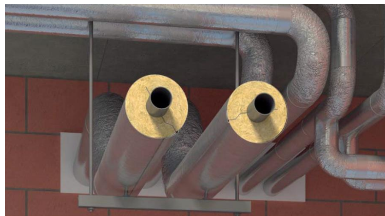
IZOLACJA RUR W INSTALACJACH C.O., C.T., C.W.U., RUROCIĄGÓW PAROWYCH, WĘZŁÓW CIEPLNYCH OTULINAMI FLEKIROCK
