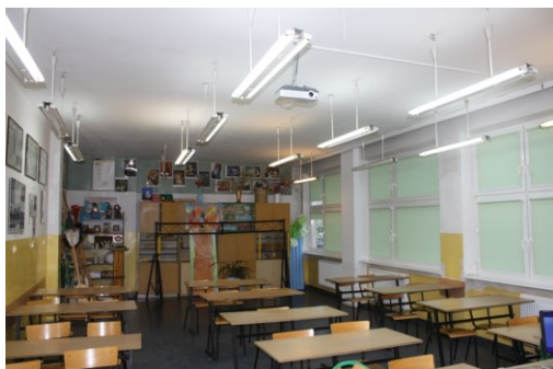
Przykładowa sala informatyczna przed modernizacją oświetlenia
